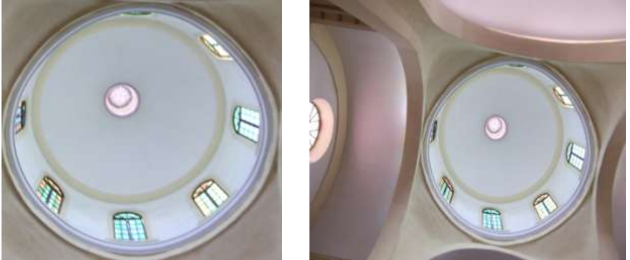
Imágenes del cimborrio
